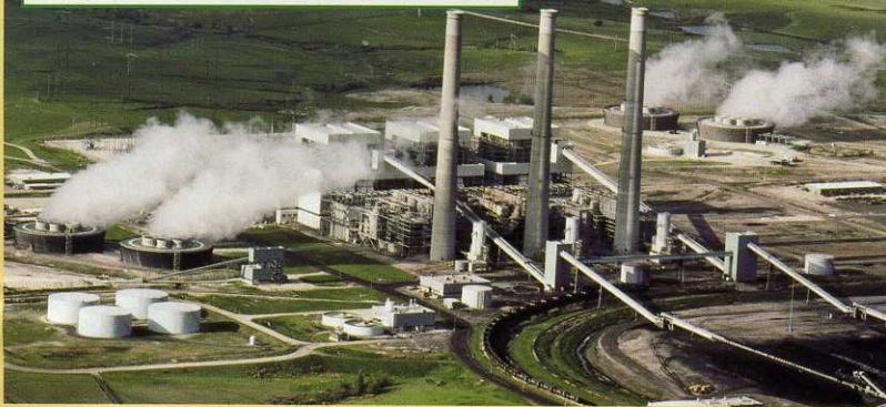
Panorámica de una central térmica
